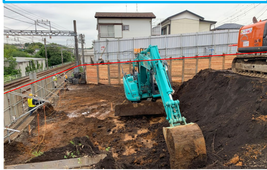
第1工区 【シールドトンネル工事の起点となります】
