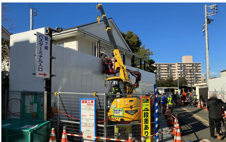
鶴ヶ峰バスターミナル改変工事が始まりました
