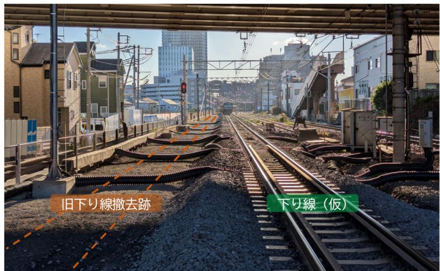
下り線の線路切替により残った旧下り線の撤去工事が完了しました。今後は、撤去後のスペースを活用し、土留壁の打ち込み、工事中に線路を支える工事桁の支持杭の打ち込み、箱型トンネル・擁壁を作っていきます。
