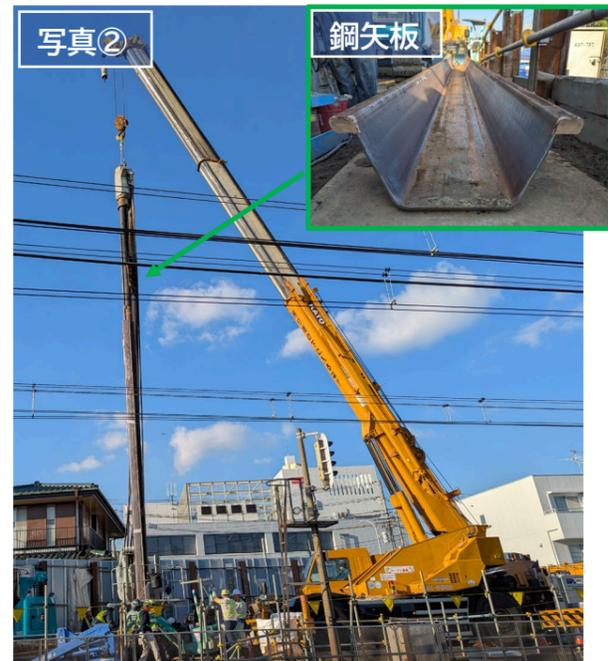
写真② 約18mの鋼矢板を地中に打ち込んでいきます。
