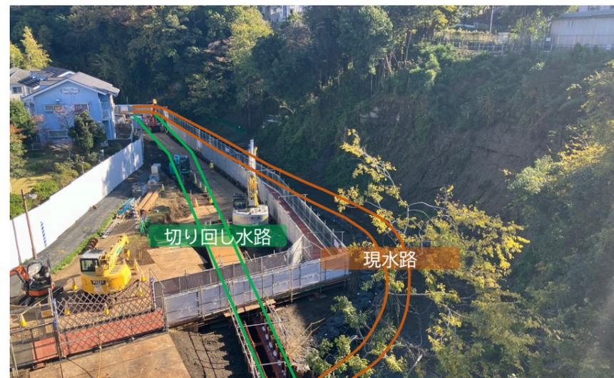
新たな鶴ヶ峰駅を親水緑道の地下に建設するための準備工事として、水路の切り回し工事を実施しています。現在生息している水生生物や植物等、環境に配慮して工事を進めていきます。
