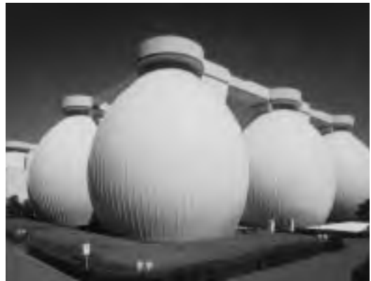
北部汚泥資源化センター消化タンク
