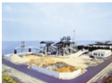
■焼却灰の有効利用 (改良土プラント)
