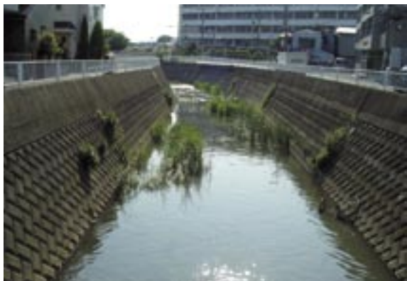
■コンクリート護岸（舞岡川 戸塚区）
