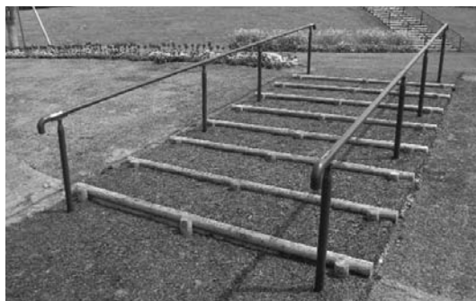
チップ材を用いた舗装
