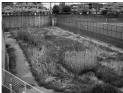
図 8-7 赤田1号 雨水調整池
