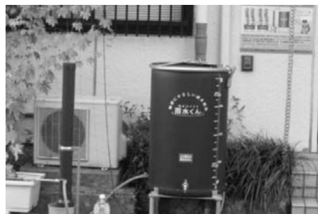
雨水貯留タンク
