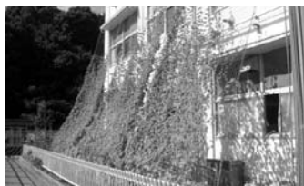
柏尾小学校 (2階の窓まで覆ってみました)
