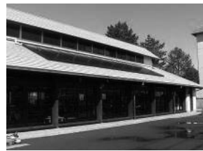
太陽光パネル
