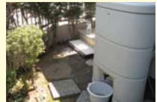
家庭に設置された雨水貯蓄タンク
