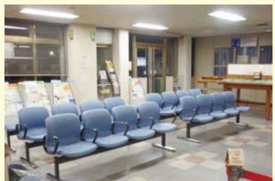
LED照明に交換した区庁舎
