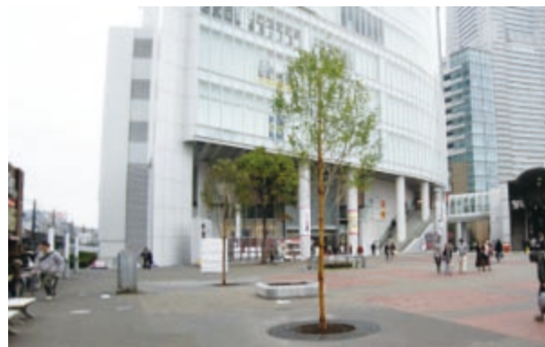
桜木町駅前広場街路樹の植栽工事
