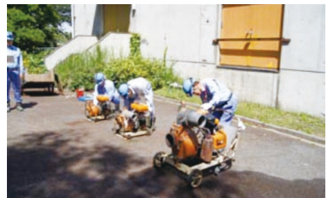
下水道BCPを取り入れた訓練状況
