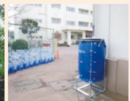
雨水タンク設置状況
