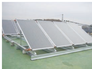
太陽熱給湯システム設置
