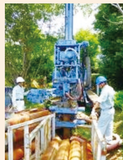
ボアホール掘削作業 (地中熱)
