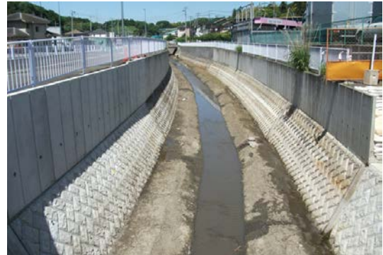
名瀬川(名瀬中村橋付近)
