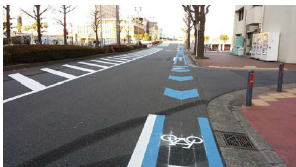
自転車通行帯整備(万国橋通)
