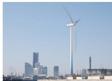
横浜市風力発電所「ハマウイング」
