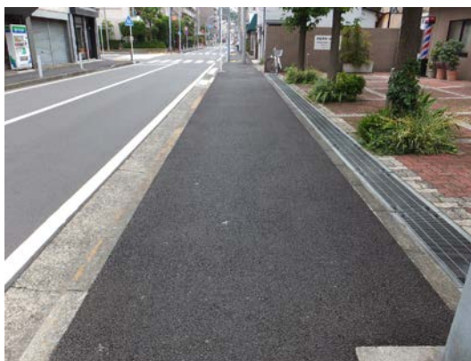
透水性舗装(歩道アスファルト)
