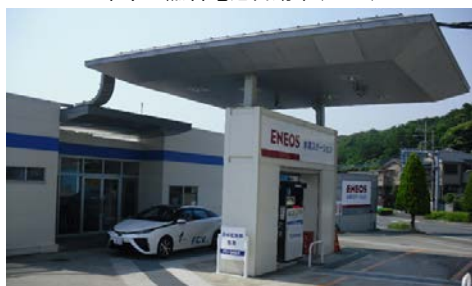
横浜旭水素ステーション
