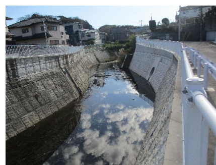
河川改修の状況（港南区）
