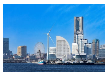
横浜市風力発電所（ハマウイング）
