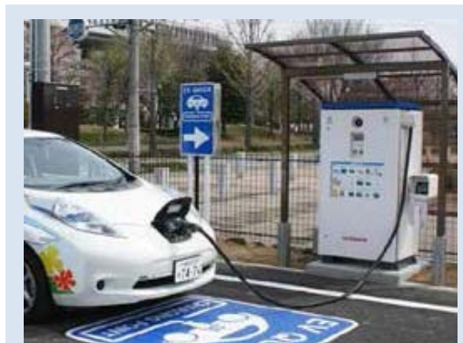
EV充電器の設置
