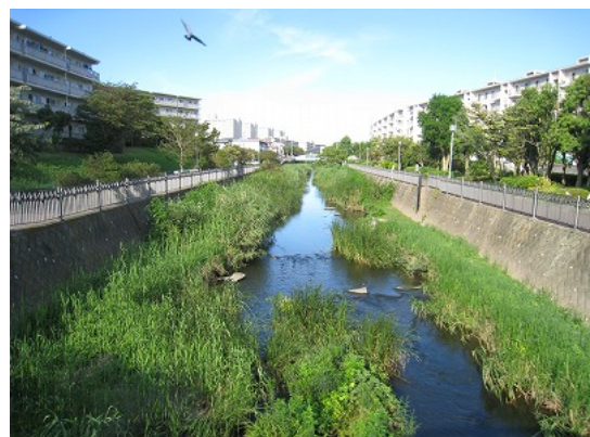
植生を施した多自然川づくり
