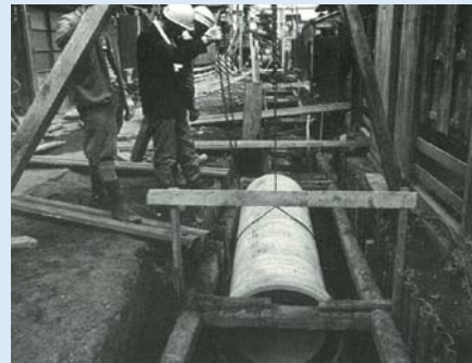
下水管の整備(1960年代) Installation of sewerage pipes (1960's)
