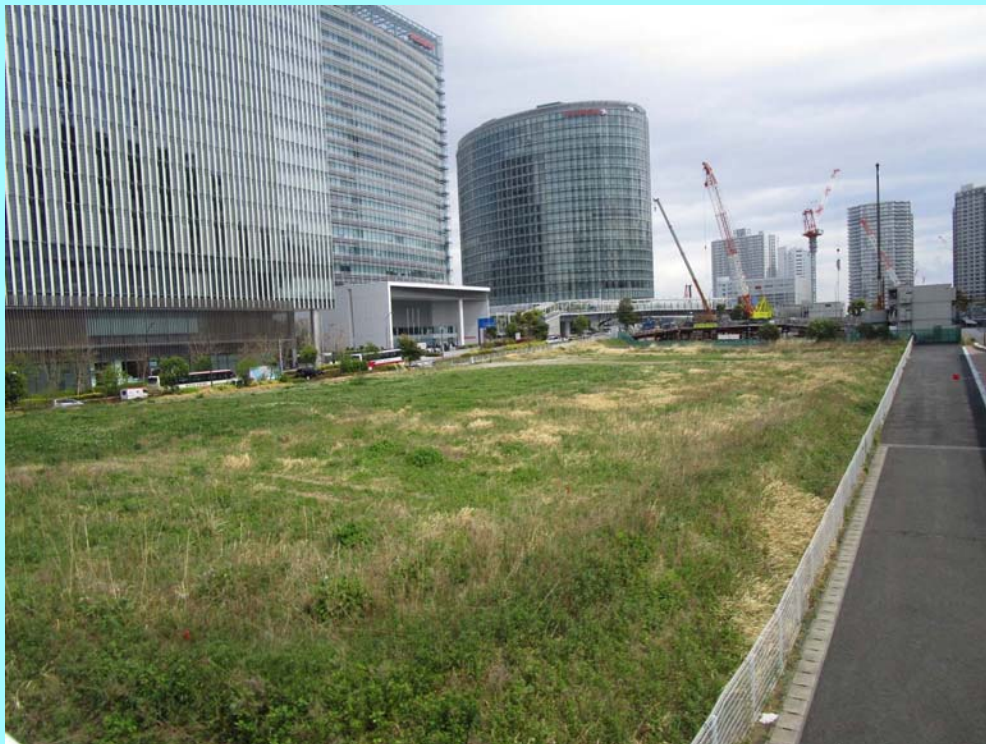
計画区域南西端より撮影（平成30年4月11日撮影）
