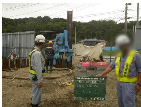
写真 2.4-11 低振動工法の導入状況
