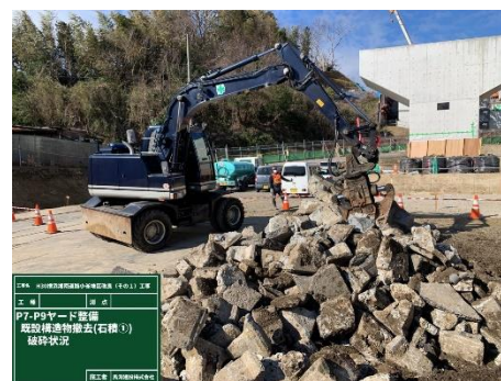
写真 2.4-11 低振動工法の導入状況
