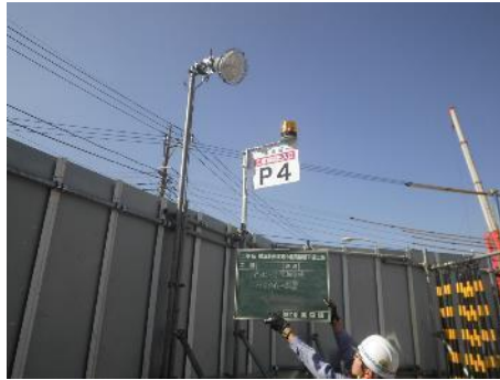
写真 2.4-15 防護柵、標識、回転灯の設置状況
