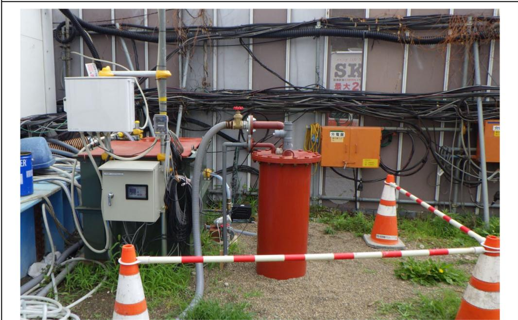
写真 2. 4. 1-2 環境保全のための措置の実施状況（リチャージウェルの実施）
