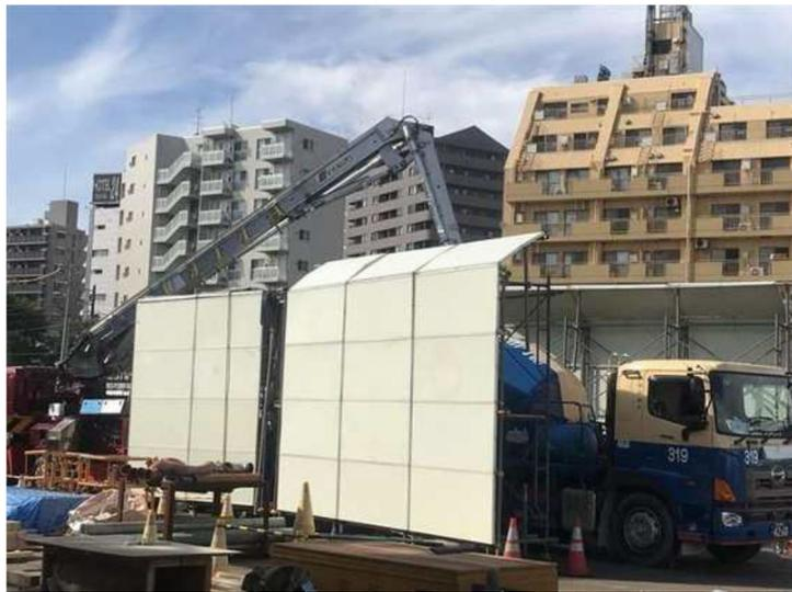
写真 2. 4. 4-1 (4) 環境保全のための措置の実施状況（建設機械稼働箇所への仮囲いの設置）
