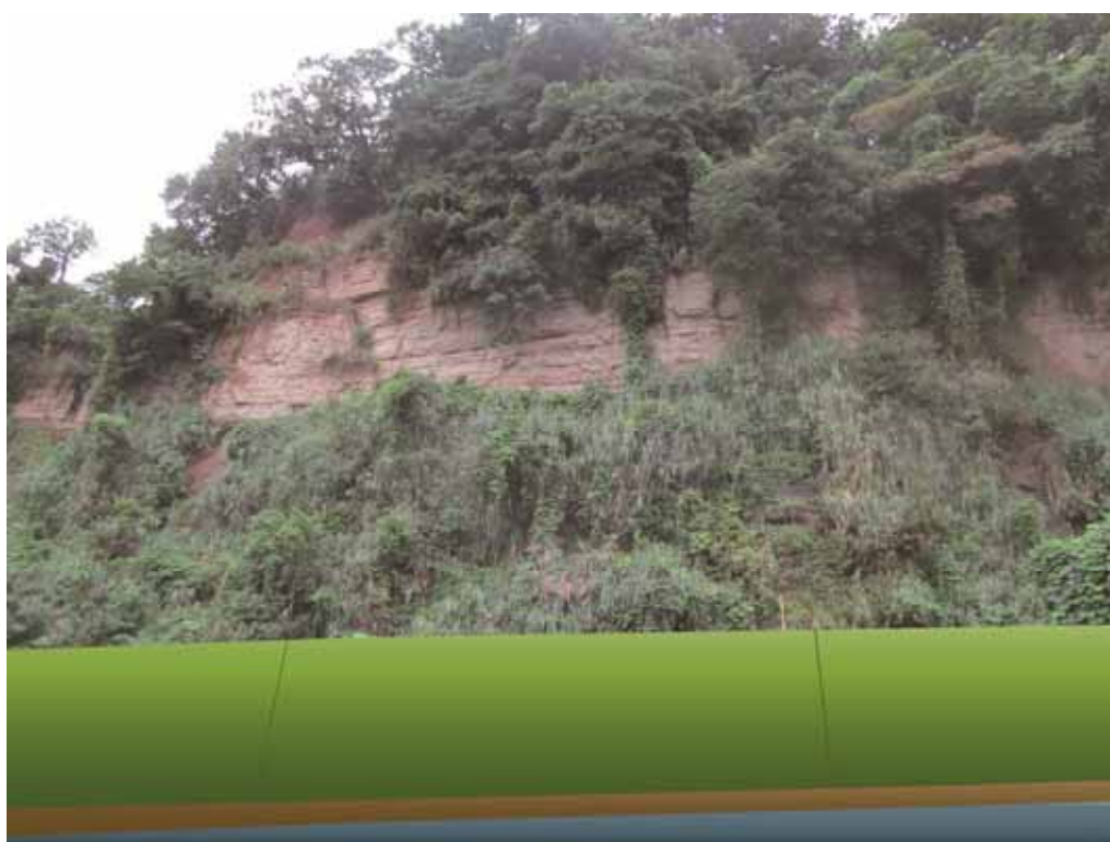
図 2-2 待受け擁壁（緑化補強土壁工）の設置イメージ
