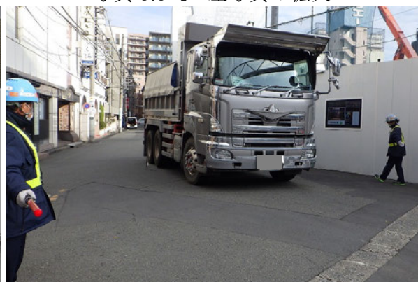
写真 3.3-6 誘導員の配置状況 (2)
