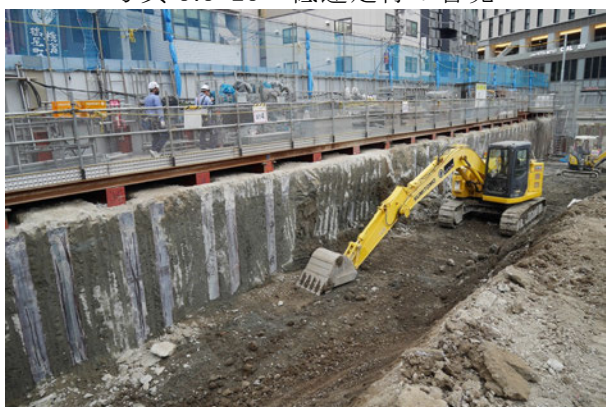
写真 3.3-25 SMW 山留壁の構築状況
