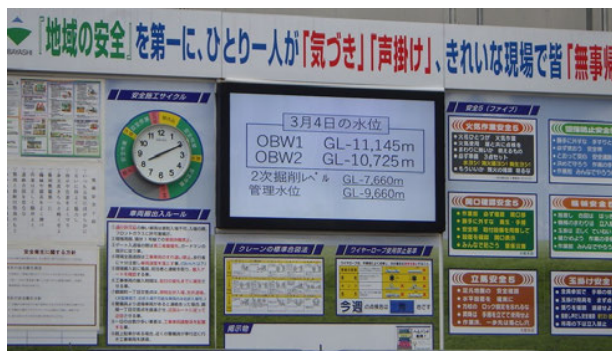
写真 3.2-3 地下水位の計測状況
