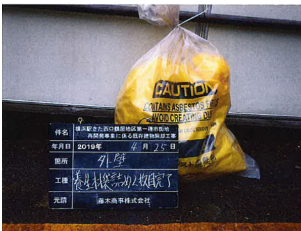
写真 3.1-5 除去したアスベストの梱包
