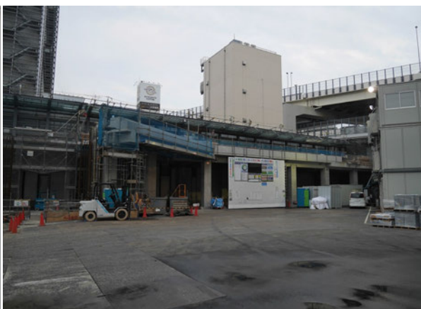
写真 3.3-24 段差のない鉄板敷の設置状況
