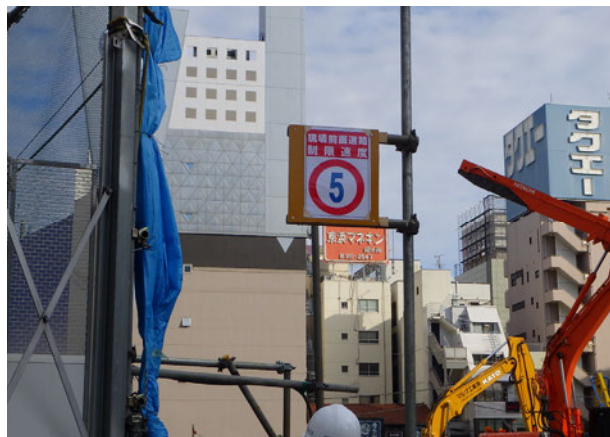
写真 3.3-31 前面道路の規制速度周知看板
