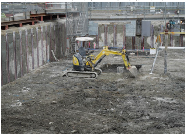
写真 3.3-21 敷地境界付近での 小型建設機械の稼働状況
