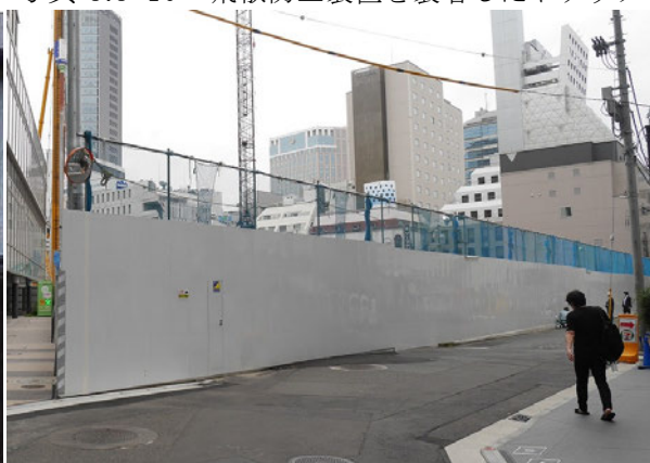
写真 3.3-12 仮囲いの設置状況
