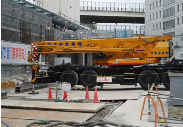
写真 3.3-17 低騒音型建設機械（１）
