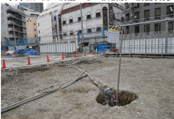
写真 3.3-26 ディープウェルの設置状況
