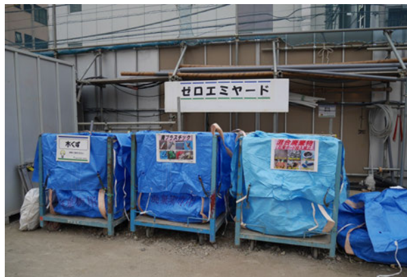
写真 3.1-2 廃棄物の分別状況
