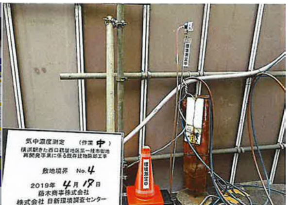
写真 3.3-16 解体時におけるモニタリング調査
