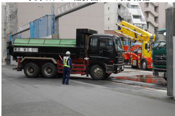
写真 3.3-5 誘導員の配置状況 (1)
