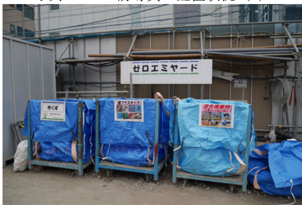
写真 3.3-8 廃棄物の分別状況
