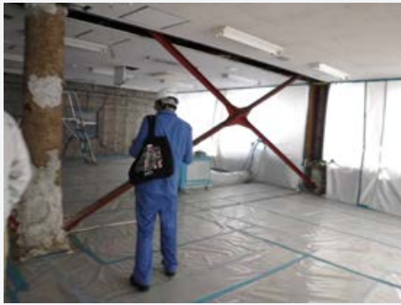
アスベスト工事の立入検査
