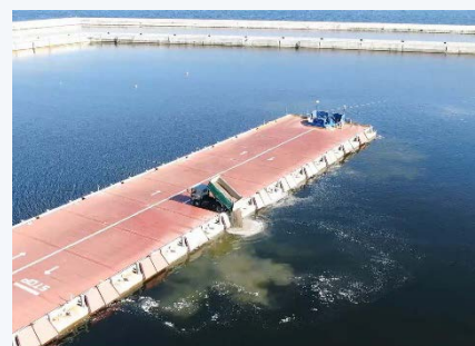
南本牧第5ブロック 廃棄物最終処分場
