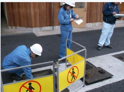
浄化槽の水質検査及び管理者へのヒアリング
