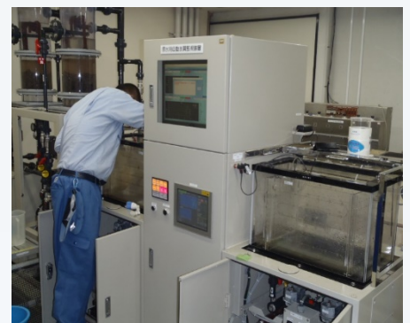
自動水質監視装置の清掃作業
