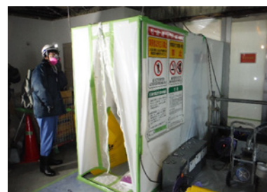
アスベスト立入調査の様子
