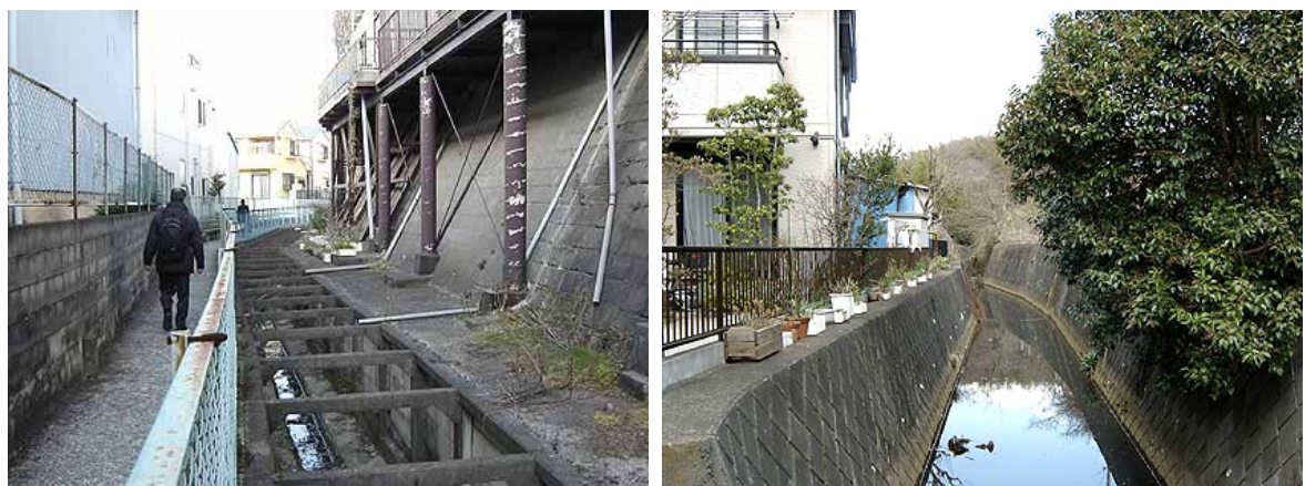
写 コンクリート化された護岸水路
