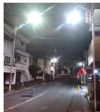
LED 照明に交換した街路灯 (鴨居商栄会（緑区）)
