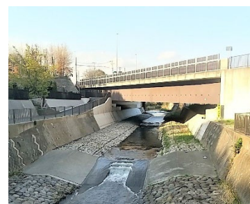
和泉川における河川改修（泉区）
