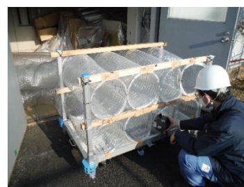
アスベスト工事現場の立入調査の様子
