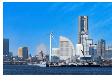
横浜市風力発電所（ハマウイング）
