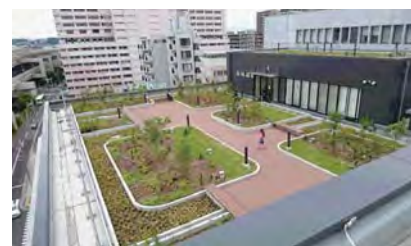
屋上緑化（南区役所）
