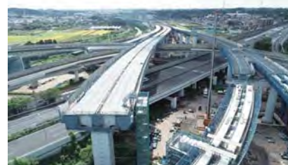
交通ネットワークの形成 横浜環状北西線横浜青葉 I C・JCT（仮称）（青葉区）
