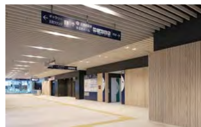
公共建築物の木質化整備工事 （南区役所）
