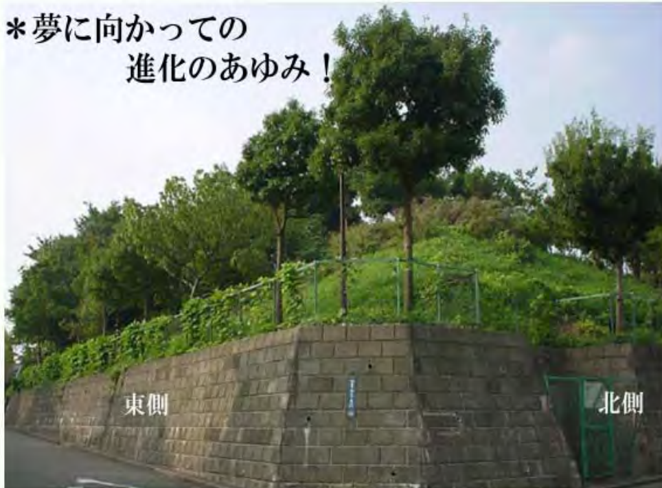
北東角の道路から見上げる 2001年9月
