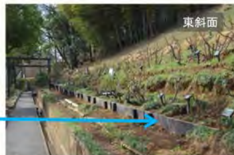
東と北斜面の土留めの作業 資材:擬装平板と杭
