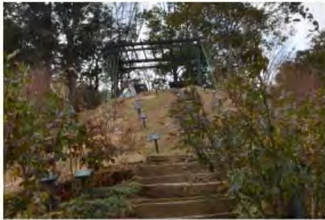
アーチ取り付け前
