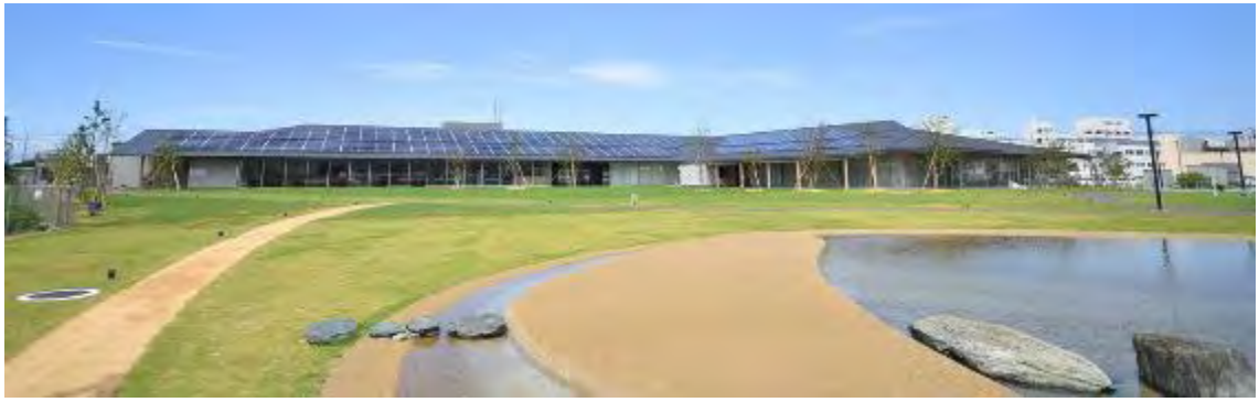
ZEB ready 対応 糸プロジェクト マルシェ (出所:糸プロジェクト HP)
