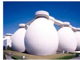
下水処理の過程で発生した下水汚泥は、濃縮・消化・脱水・焼却等の処理をして減量化・安定化をはかっています。横浜市では2箇所の汚泥資源化センターに集約し処理しており、その過程で発生した消化ガスは燃料として、焼却灰は建設資材原料等に有効利用しています。また、汚泥を炭化させることで化石燃料の代替燃料として活用する取り組みも進めています。
