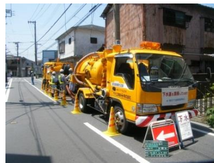
図 2-3 吸引車による下水道管の清掃
