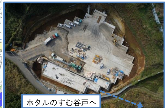
図 2-39 雨水調整池（築造中にドローンにて撮影）
