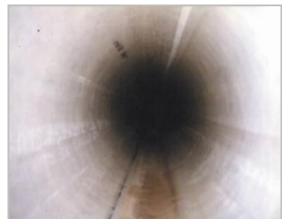
管更生工法による施工
