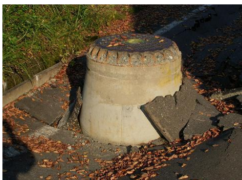
地盤の液状化によるマンホールの浮上 (中越地震 新潟県川口町)
