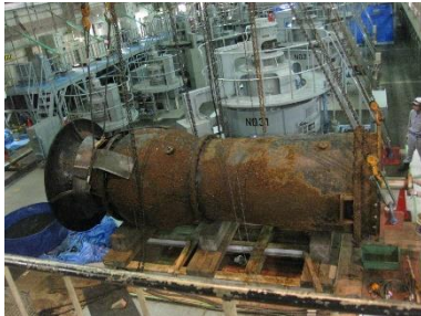
ポンプ再整備前
