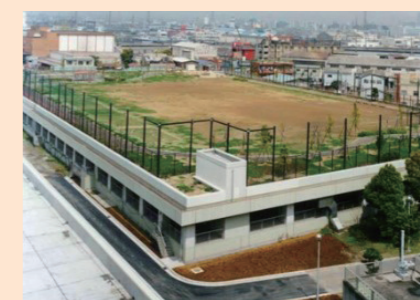
北部第一水再生センター 上部利用 (元宮さわか公園)
