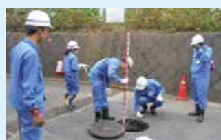
下水道管実地調査訓練
