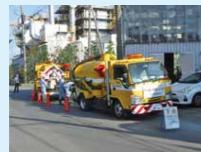
吸引車による下水道管の清掃
