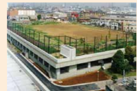
北部第一水再生センター 上部利用 (元宮さわか公園)
