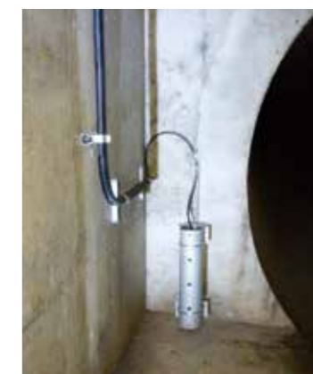
水位計設置状況
