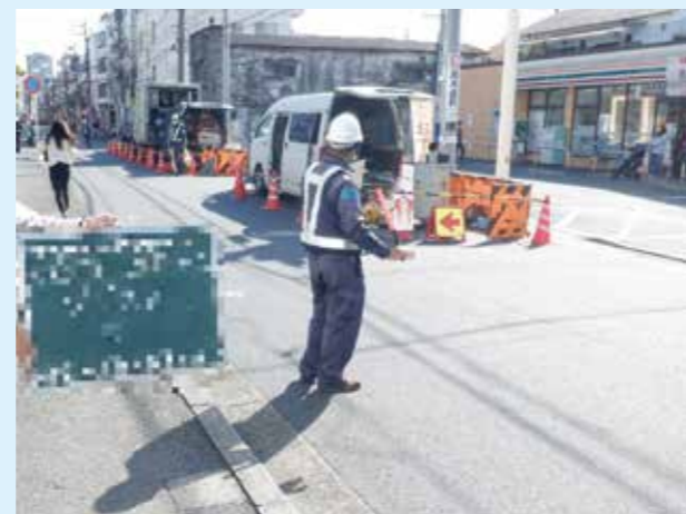
施工状況(形成工法)
