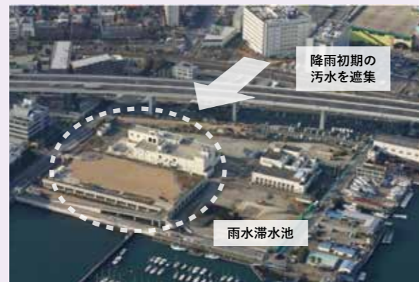
雨水滞水池の整備事例 (磯子第二ポンプ場)
