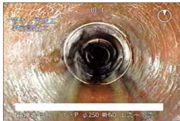
更生前の下水道管
