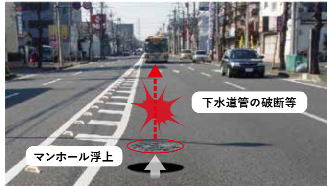
緊急輸送路の下水道管の耐震化
