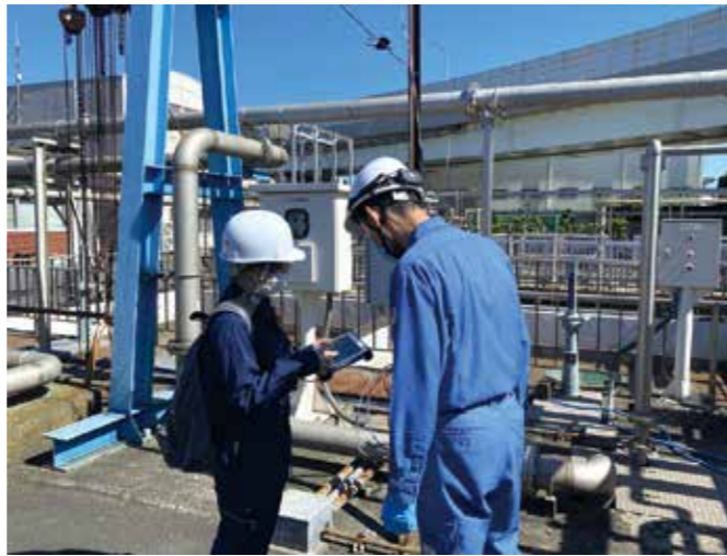
工場への立入検査の様子
