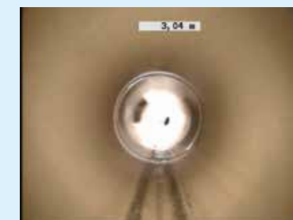
ノズルカメラでの下水道管内撮影画像
