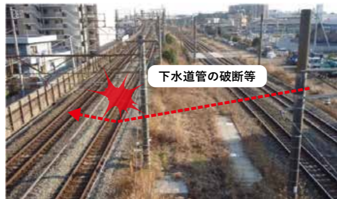
鉄道軌道下の下水道管の耐震化
