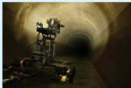
中大口径管の調査状況
