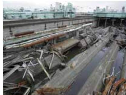
2011（平成23）年 東日本大震災被害状況（施設）
