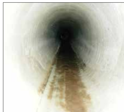
更生後の下水道管
