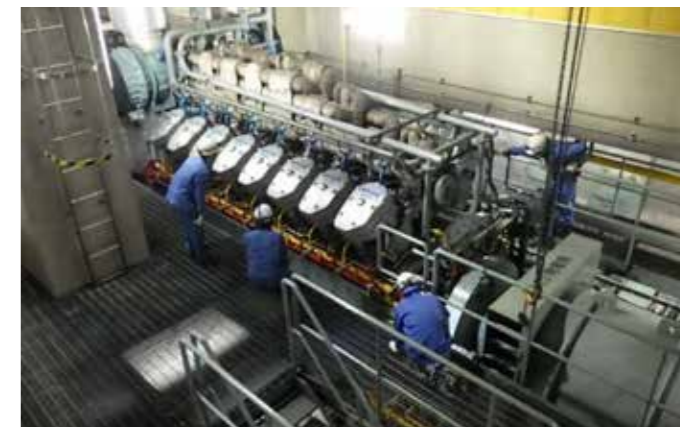
自家発電機設備の点検
