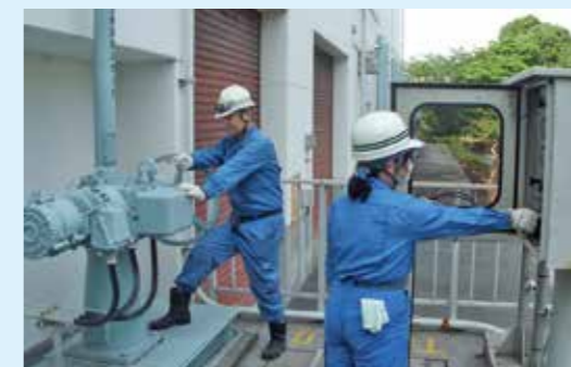
主要設備の点検 ゲート設備
