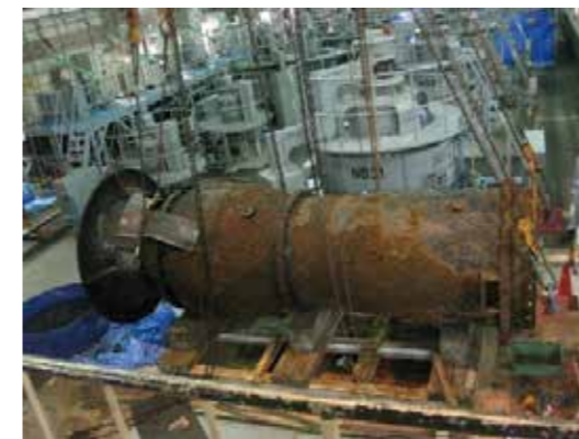
再整備前のポンプ設備
