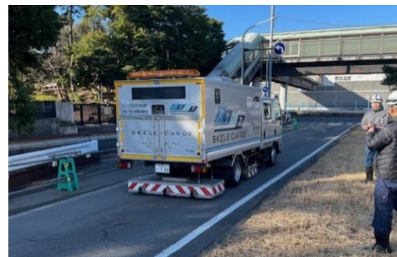
写真4 空洞探査車による調査
