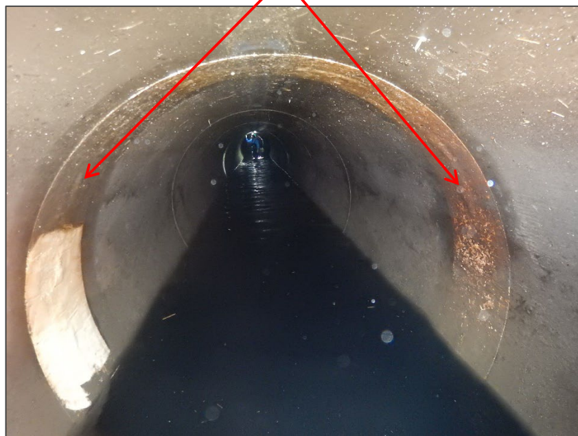
写真 部分修繕の例
