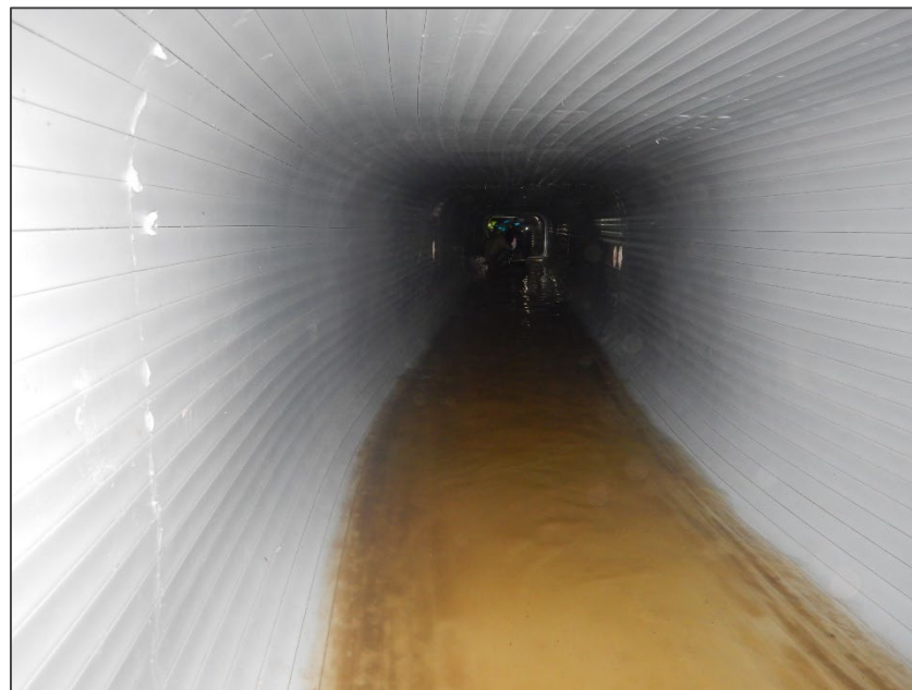
写真 改築の例（管更生工事）
