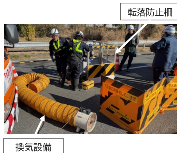
写真3 下水道管の点検状況
