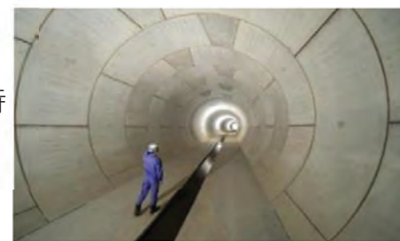
雨水貯留施設（新羽末広幹線）の内部
