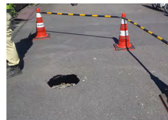
取付管破損による道路陥没
