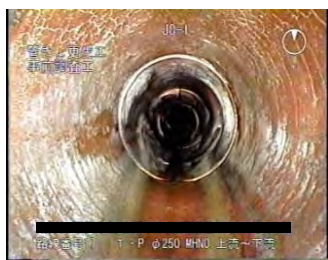
更生工法による下水道管の再整備
