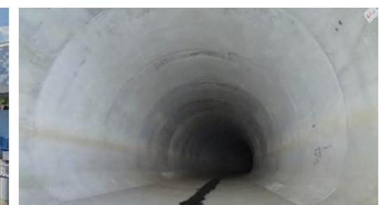
▲帷子川分水路のトンネル内部
