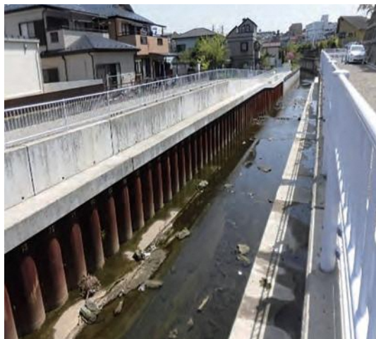
▲直壁護岸（今井川）
