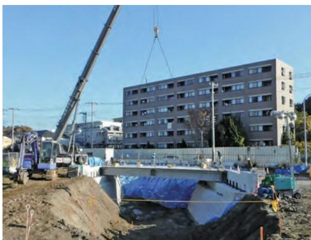
▲橋げたの架設状況（奈良川）
