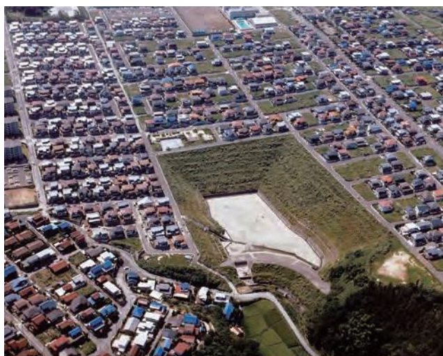
▲開発にあわせて設置された雨水調整池(栄区 桂台2号雨水調整池)
