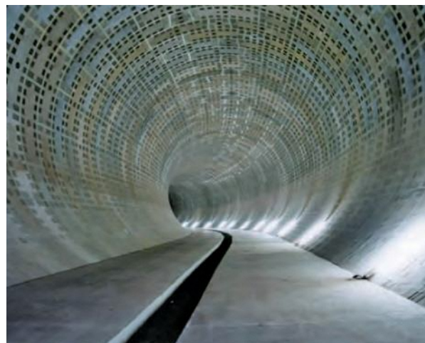
▲今井川地下調節池の内部
