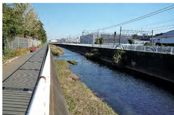
▲ 鉄道に隣接する特殊堤（平戸永谷川）
