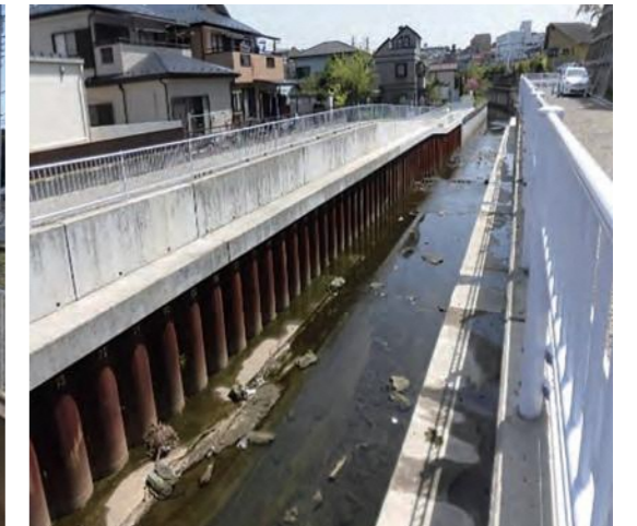
▲直壁護岸(今井川)
