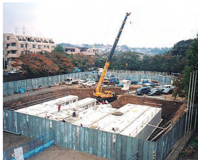
▲校庭での施設整備(北方小学校)
