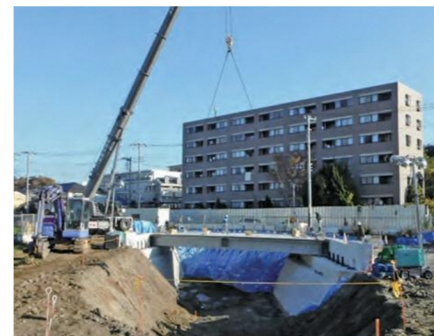
▲橋げたの架設状況(奈良川)
