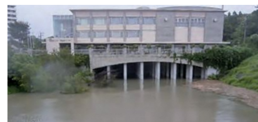
▲上部を地域ケアプラザとして利用(野庭団地第一雨水調整池)
