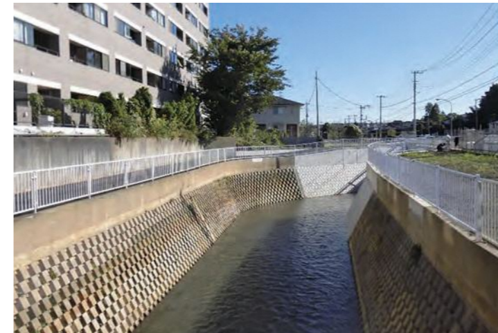
▲ブロック積護岸(奈良川)
