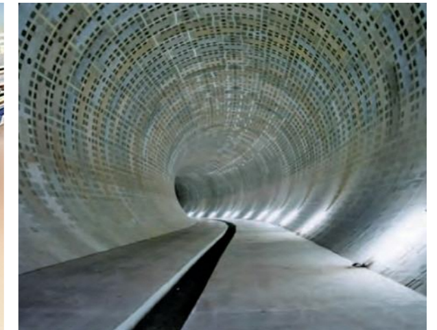
▲今井川地下調節池の内部
