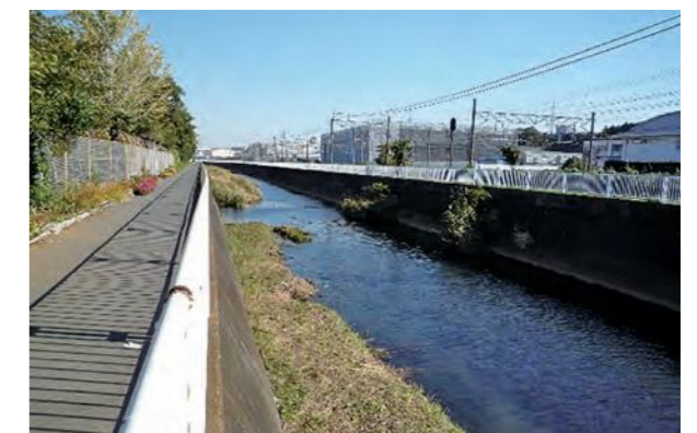
▲鉄道に隣接する特殊堤(平戸永谷川)
