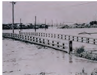
昭和33年9月狩野川台風の浸水状況 (鶴見川:鶴見区森永橋) (出典:京浜河川事務所HP)
