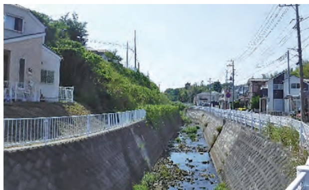
▲住宅地を流れる中堀川
