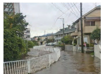
平成26年台風18号の浸水状況 (帷子川:旭区川井本町)
