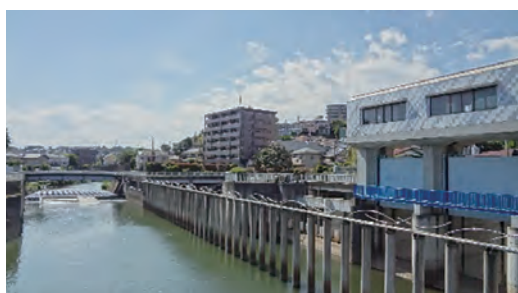
▲帷子川分水路入口
