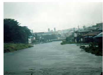
平成3年9月洪水の浸水状況 (帷子川:公園橋付近)
