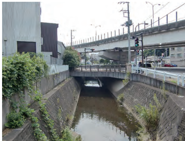
▲環状2号線との交差部
