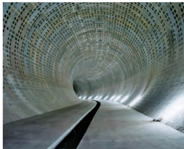
▲今井川地下調節池の内部
