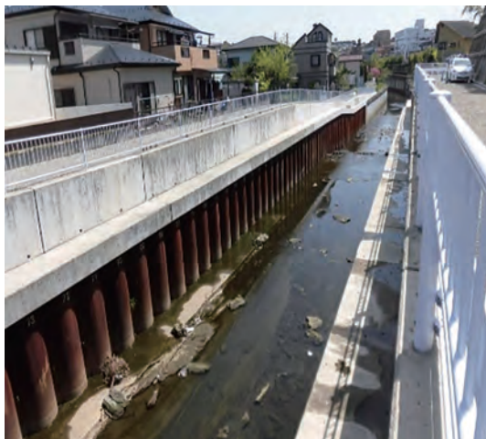
▲直壁護岸（今井川）
