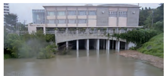
▲ 上部を地域ケアプラザとして利用(野庭団地第一雨水調整池)
