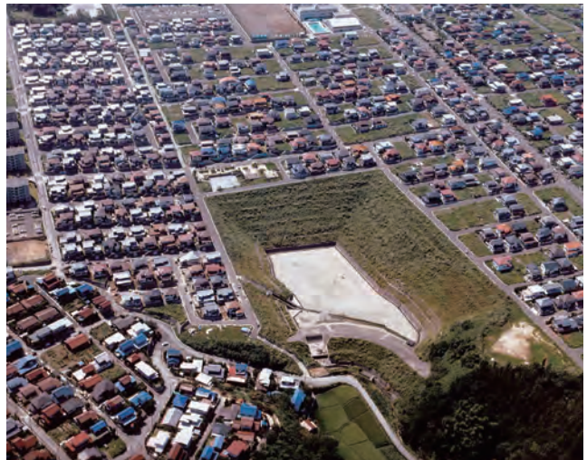
▲開発にあわせて設置された雨水調整池(栄区 桂台2号雨水調整池)
