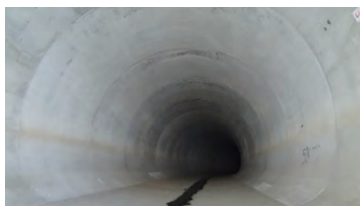
▲帷子川分水路のトンネル内部
