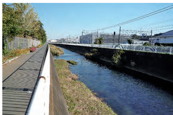
▲ 鉄道に隣接する特殊堤（平戸永谷川）
