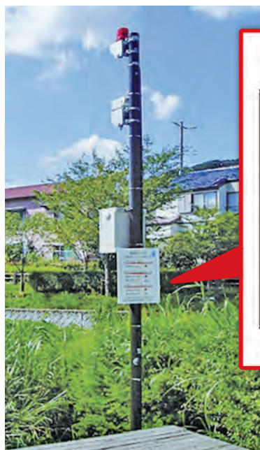
▲ 設置されている警報装置
