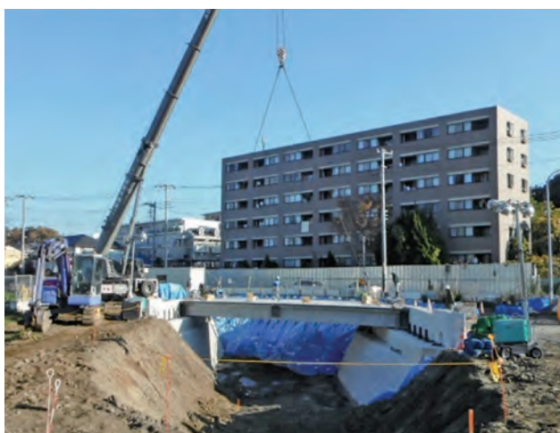
▲橋げたの架設状況（奈良川）
