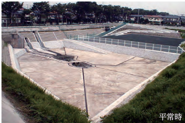
▲ 雨水調整池の平常時と満水時の様子
