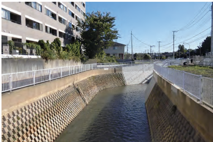
▲ブロック積護岸（奈良川）
