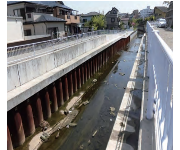
▲直壁護岸(今井川)
