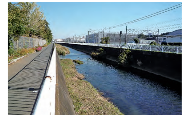
▲鉄道に隣接する特殊堤(平戸永谷川)
