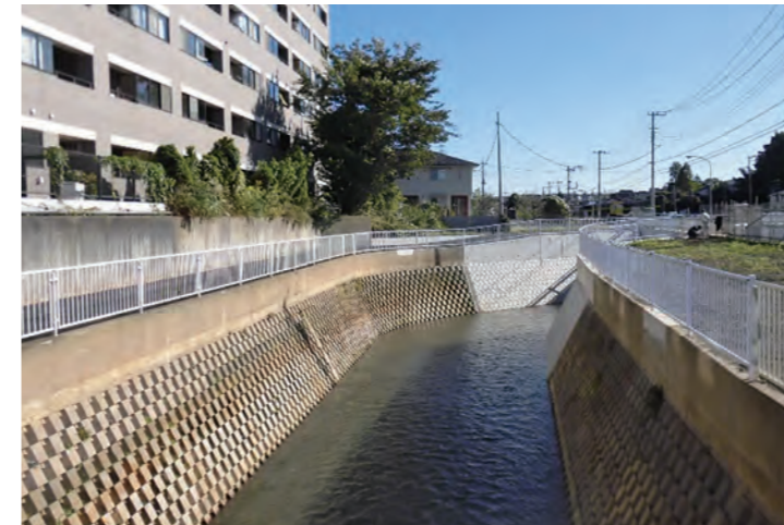
▲ブロック積護岸(奈良川)
