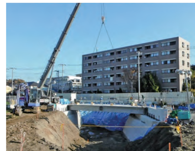
▲橋げたの架設状況(奈良川)
