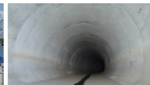
▲帷子川分水路のトンネル内部
