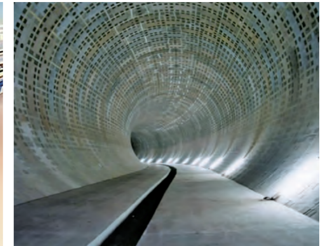
▲今井川地下調節池の内部
