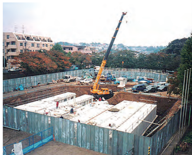
▲校庭での施設整備(北方小学校)
