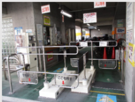
ゲート式の導入事例 (元町・中華街駅自転車駐車場)
