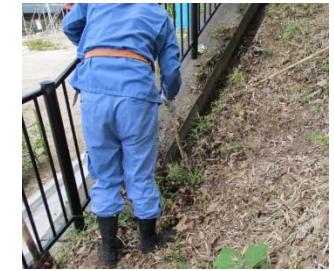
側溝の清掃作業
