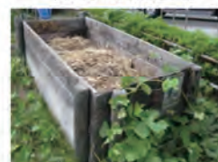
使われなくなった堆肥置場
