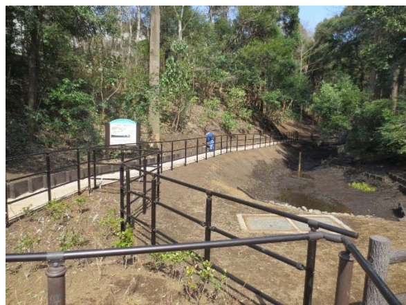
改修後 遊水地
