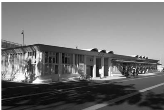
レストハウス全景 トイレや周辺園地の清掃も事業者が実施
