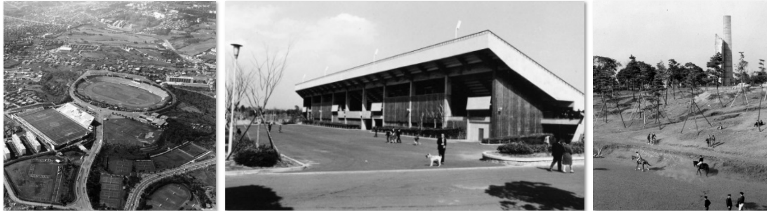
▲ 陸上競技場/球技場/テニスコート/野球場が整備されている ▲ 建設当時の三ツ沢公園球技場 ▲ 馬術練習場/戦没者慰霊塔
