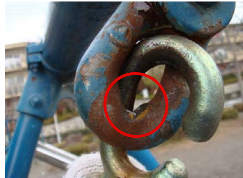
▲ 吊金具の摩耗
