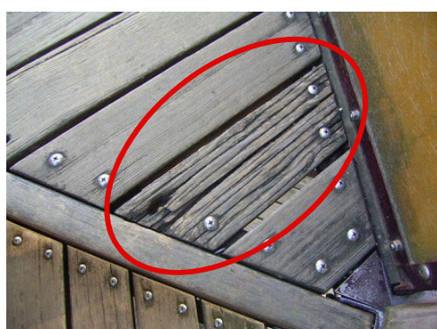
▲ 床材の腐朽
