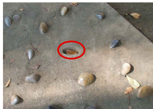
▲ 踏み石の欠落（健康歩道）
