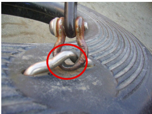
▲ 取付金具の摩耗
