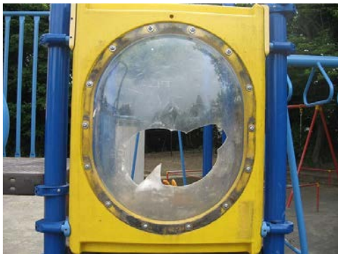
▲ ドームパネル破損
