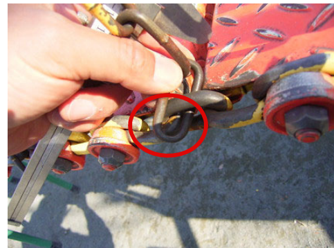
▲ 吊り橋チェーン摩耗
