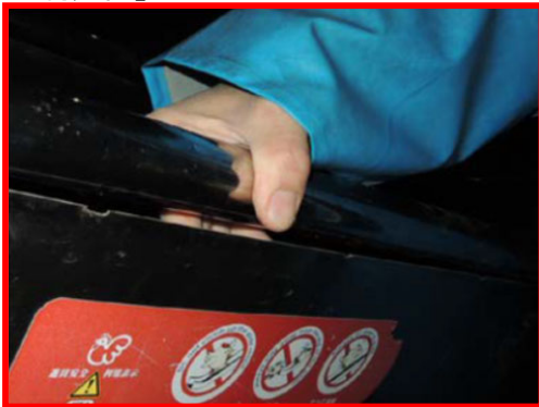
▲ 側板の溶接部破損
