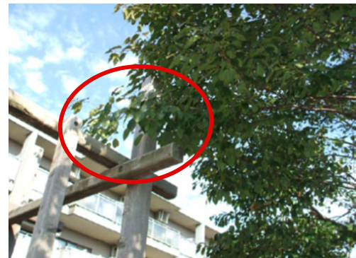
▲ 樹木の枝が支障となっている
