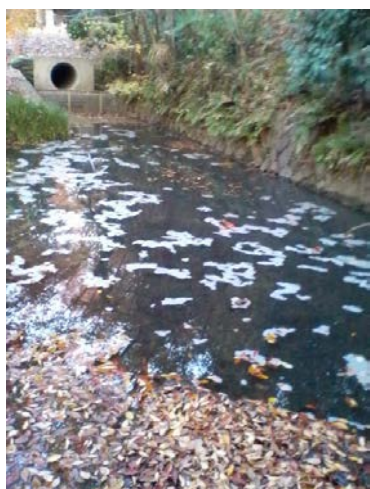
▲ 水景施設 汚濁
