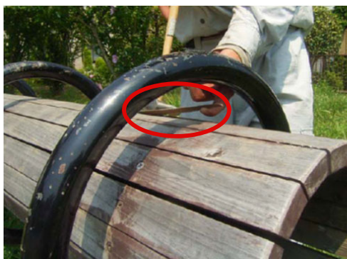
▲ 座板表面の割れ
