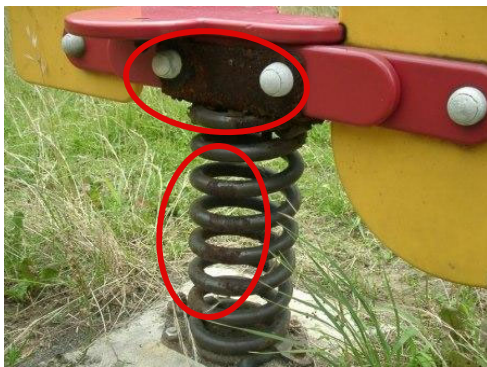
▲ スプリング及び上物取付金具の錆
