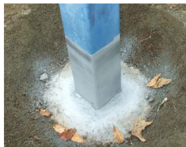
◀ 柱の根際部の 防食テープ 措置事例
