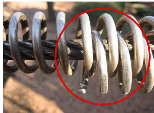
▲ 緩衝部（スプリング）の破損
