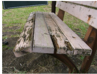
腐朽の中期段階
