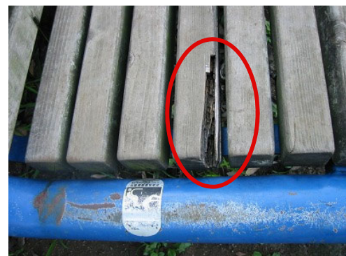
▲ 座板の腐食
