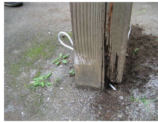
腐朽の最終段階
