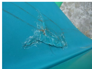
F R P の劣化状況
