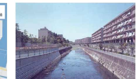
いたち川(栄区)再整備前 昭和57(1982)年
