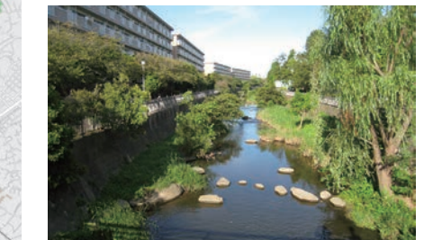
いたち川(栄区)再整備後 平成27(2015)年
