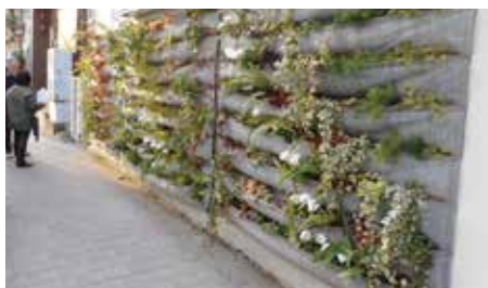
弁三ビルの壁面緑化
