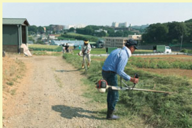
道路法面の草刈り（保土ヶ谷区峰沢町）
